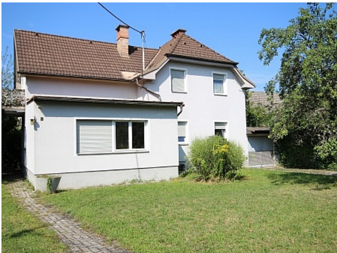
Wohnhaus/Sanierungsbedürftig in bester Lage
