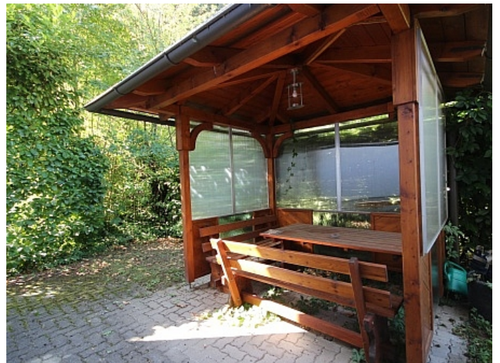
Wohnhaus/Sanierungsbedürftig in bester Lage
