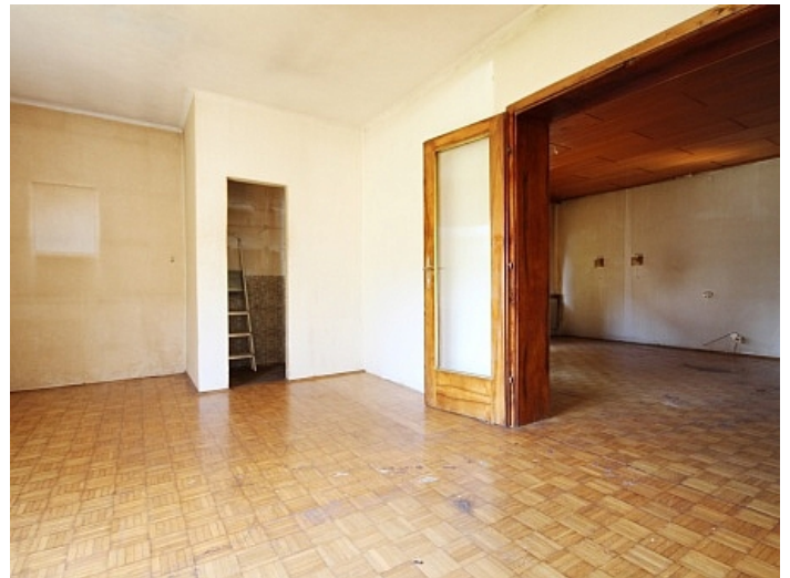
Wohnhaus/Sanierungsbedürftig in bester Lage
