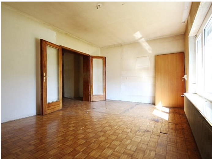
Wohnhaus/Sanierungsbedürftig in bester Lage
