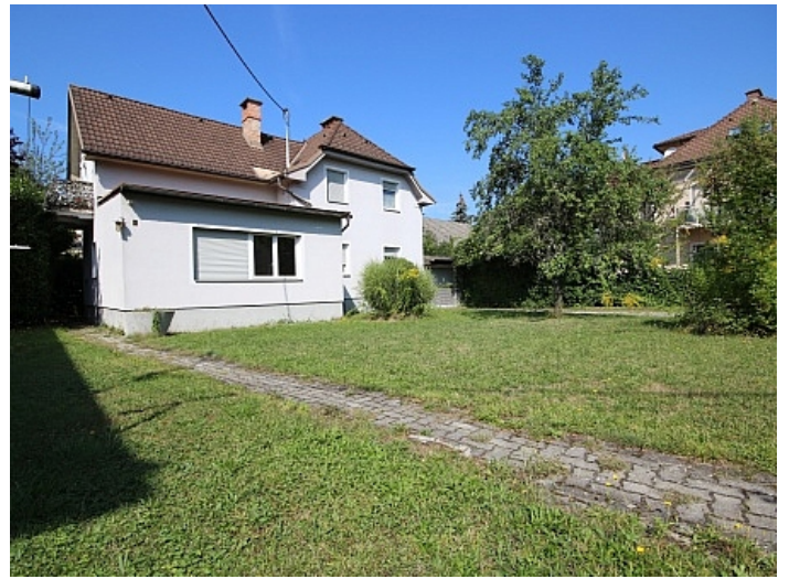
Wohnhaus/Sanierungsbedürftig in bester Lage
