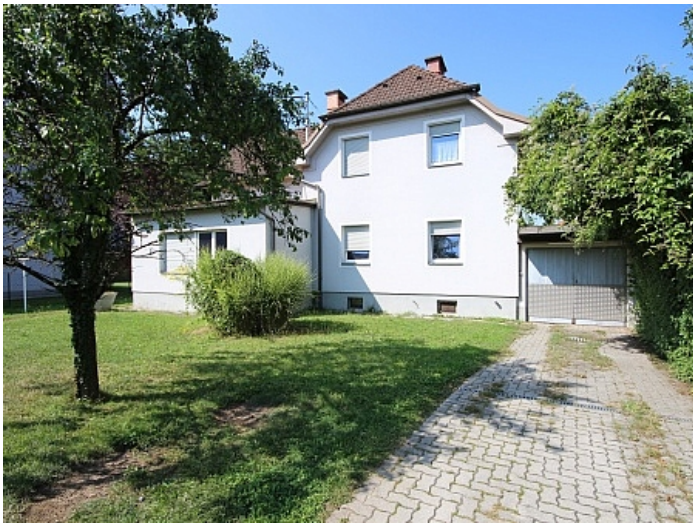
Wohnhaus/Sanierungsbedürftig in bester Lage
