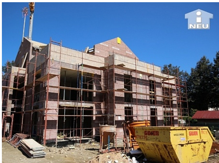
Rohnbbau Fertigstellung geschafft
