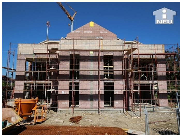
Rohnbbau Fertigstellung geschafft
