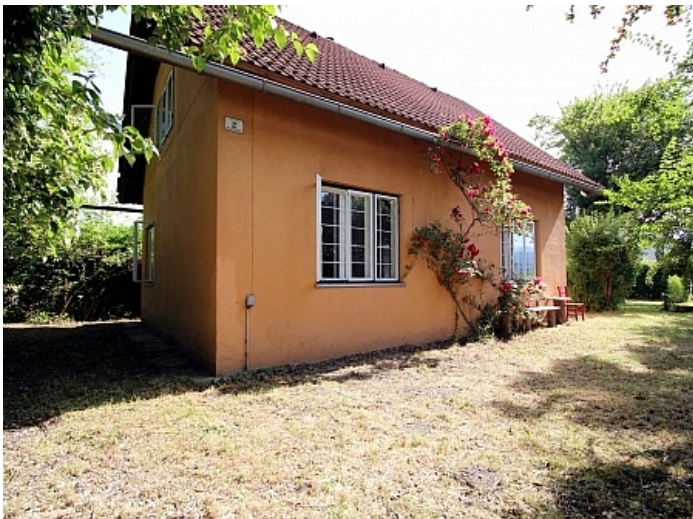
Ansicht Haus Süd/West
