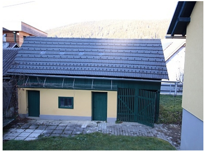
Schönes saniertes 120m 2 Wohnhaus im Gurktal - Weitensfeld
