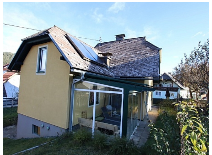
Schönes saniertes 120m 2 Wohnhaus im Gurktal - Weitensfeld
