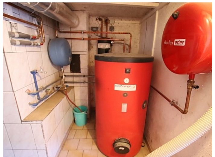
Schönes saniertes 120m 2 Wohnhaus im Gurktal - Weitensfeld
