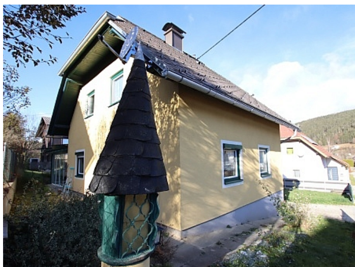
Schönes saniertes 120m 2 Wohnhaus im Gurktal - Weitensfeld
