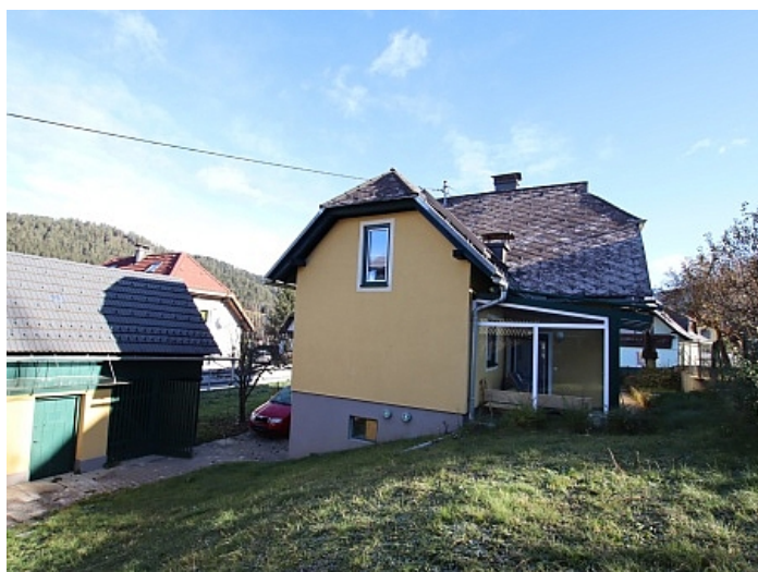
Schönes saniertes 120m 2 Wohnhaus im Gurktal - Weitensfeld
