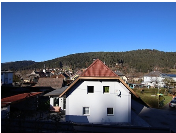
Schönes saniertes 120m 2 Wohnhaus im Gurktal - Weitensfeld
