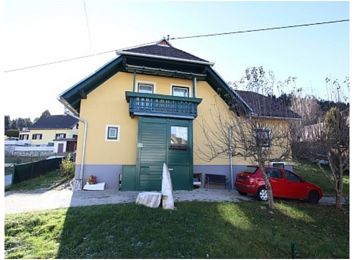
Schönes saniertes 120m 2 Wohnhaus im Gurktal - Weitensfeld
