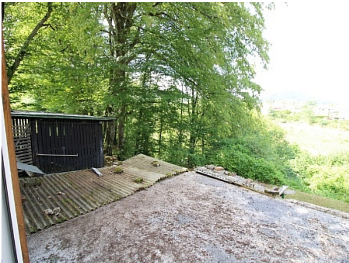
Viktring, Abrisshaus in Ruhelage!
