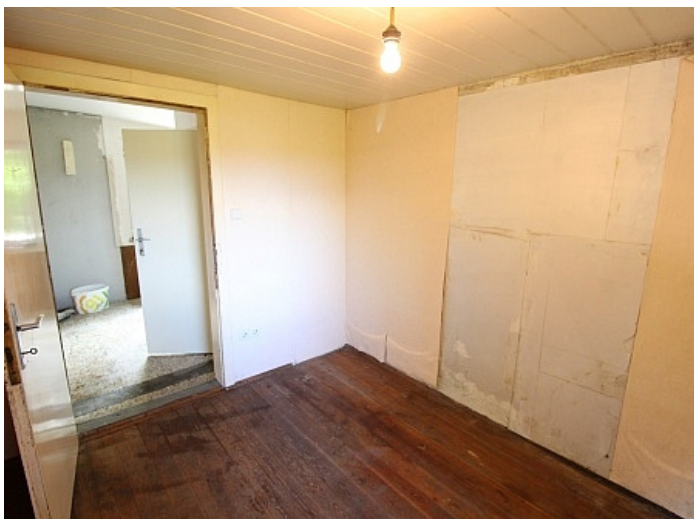
Viktring, Abrisshaus in Ruhelage!
