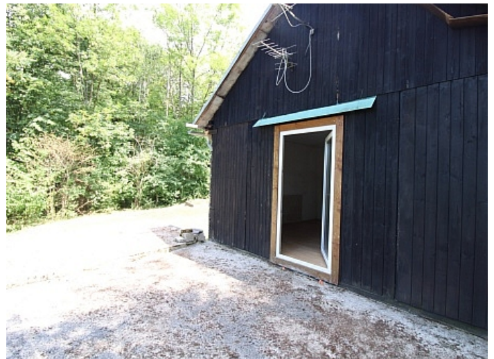
Viktring, Abrisshaus in Ruhelage!
