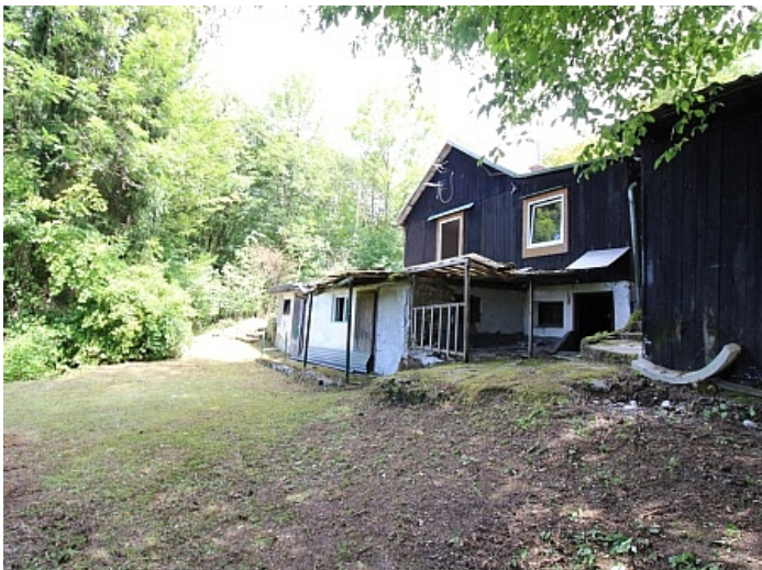
Viktring, Abrisshaus in Ruhelage!
