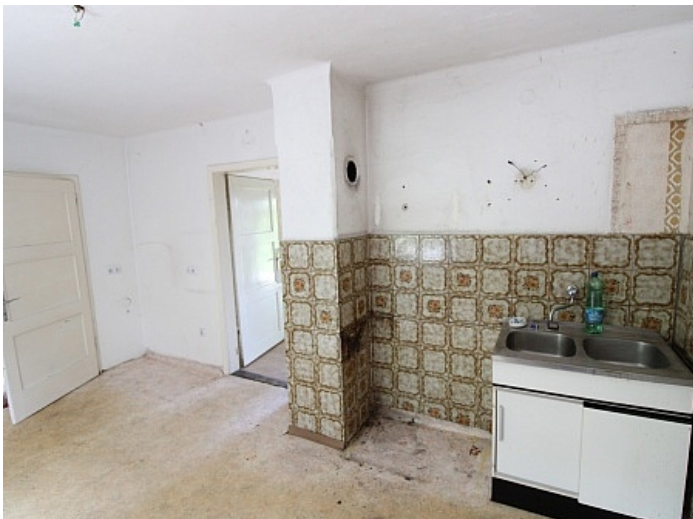
Viktring, Abrisshaus in Ruhelage!
