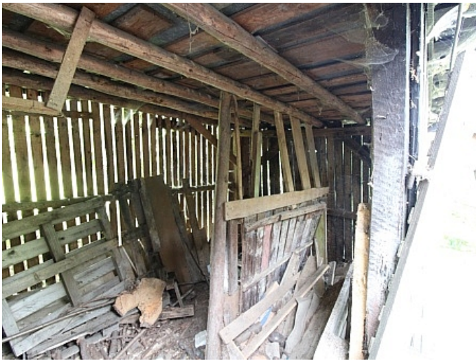
Viktring, Abrisshaus in Ruhelage!
