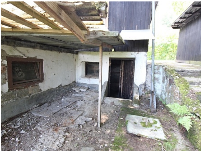
Viktring, Abrisshaus in Ruhelage!
