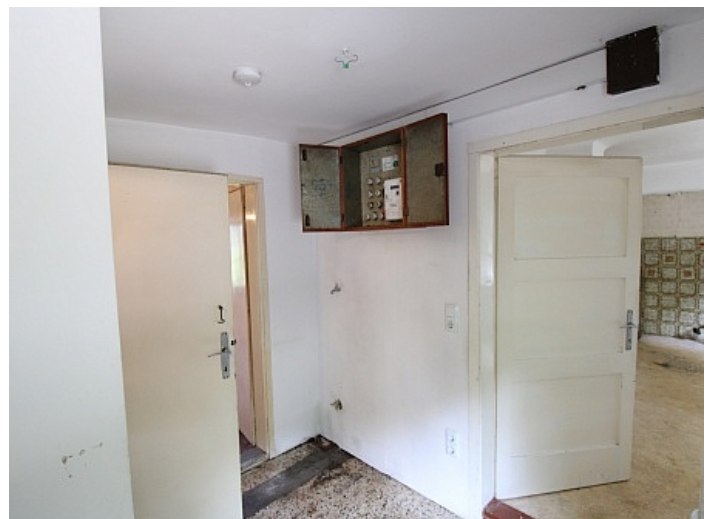
Viktring, Abrisshaus in Ruhelage!
