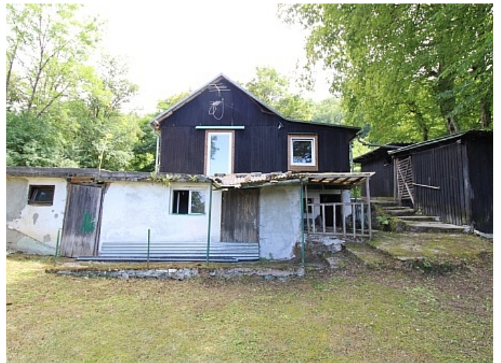
Viktring, Abrisshaus in Ruhelage!
