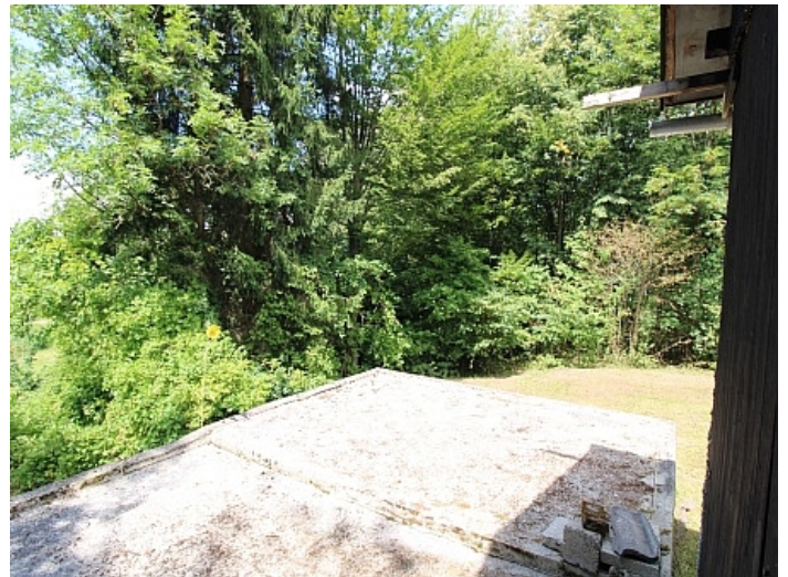
Viktring, Abrisshaus in Ruhelage!
