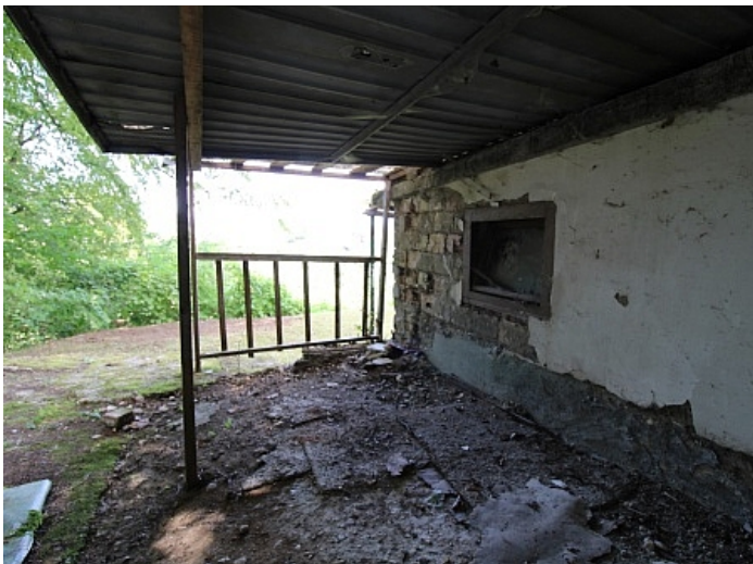
Viktring, Abrisshaus in Ruhelage!
