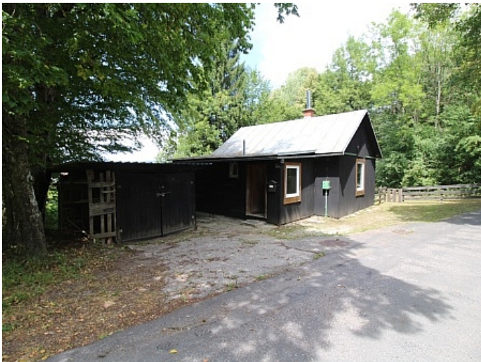
Viktring, Abrisshaus in Ruhelage!
