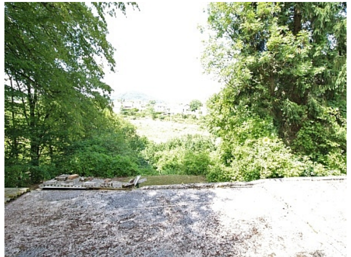
Viktring, Abrisshaus in Ruhelage!
