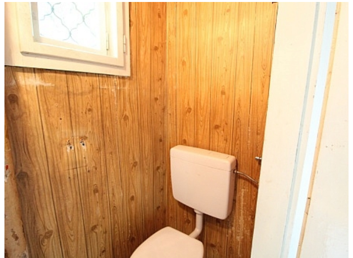
Viktring, Abrisshaus in Ruhelage!
