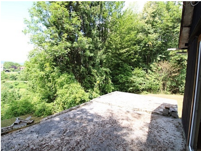
Viktring, Abrisshaus in Ruhelage!
