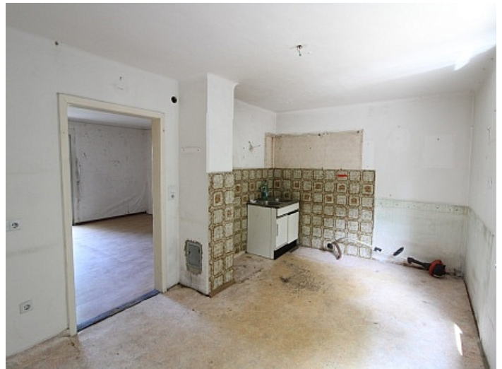
Viktring, Abrisshaus in Ruhelage!
