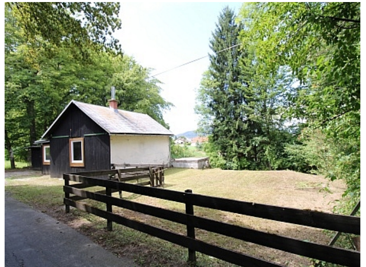
Viktring, Abrisshaus in Ruhelage!
