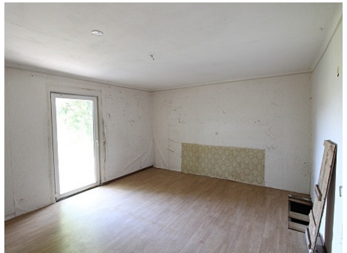
Viktring, Abrisshaus in Ruhelage!
