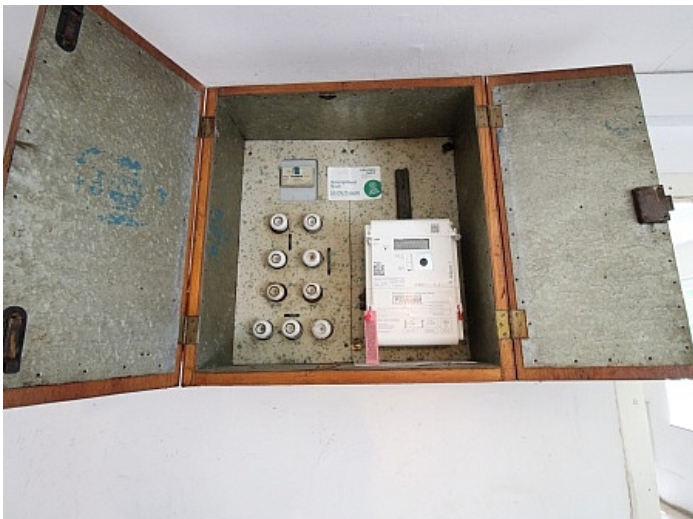
Viktring, Abrisshaus in Ruhelage!
