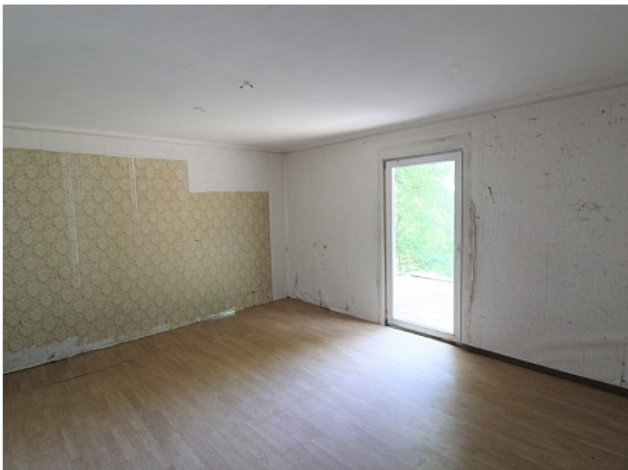
Viktring, Abrisshaus in Ruhelage!
