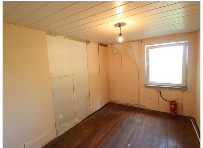
Viktring, Abrisshaus in Ruhelage!
