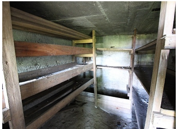
Viktring, Abrisshaus in Ruhelage!
