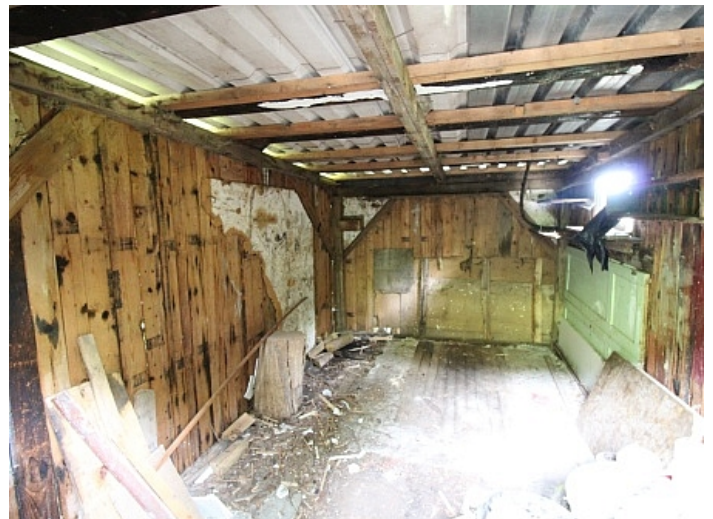
Viktring, Abrisshaus in Ruhelage!
