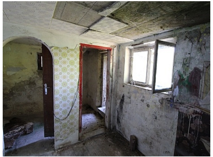
Viktring, Abrisshaus in Ruhelage!
